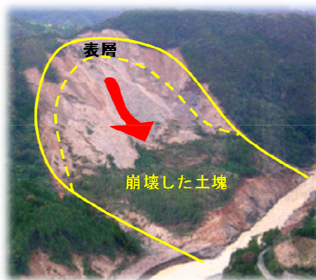
深層崩壊の例
