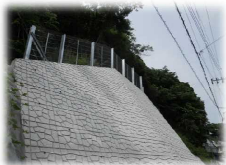
コンクリート張工
