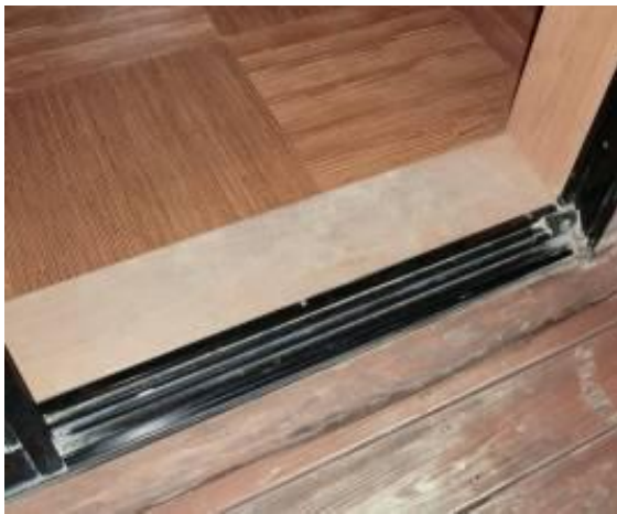
段差を極力なくした出入口
