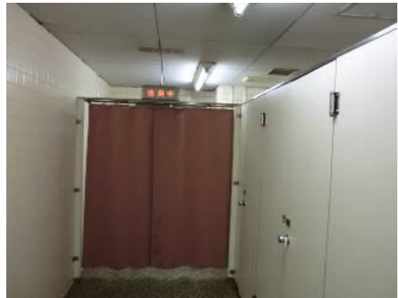
トイレ改修例
