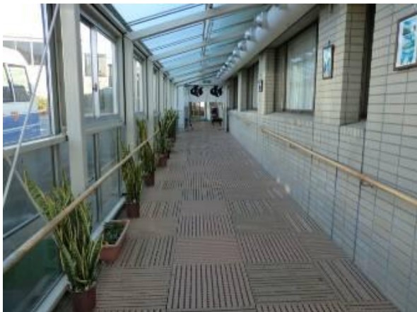
廊下の手すり
