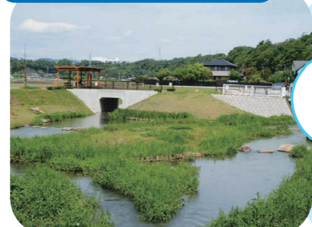
多自然川づくり(厚木市 善明川)
