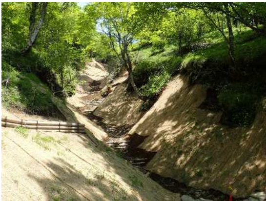
丸太積工とヤシ繊維の植生ネット工による 土壌保全工の状況
