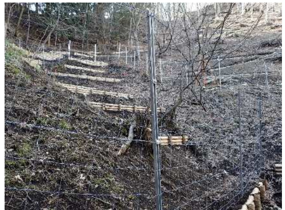
植生保護柵と丸太筋工による土壌保全工の 状況
