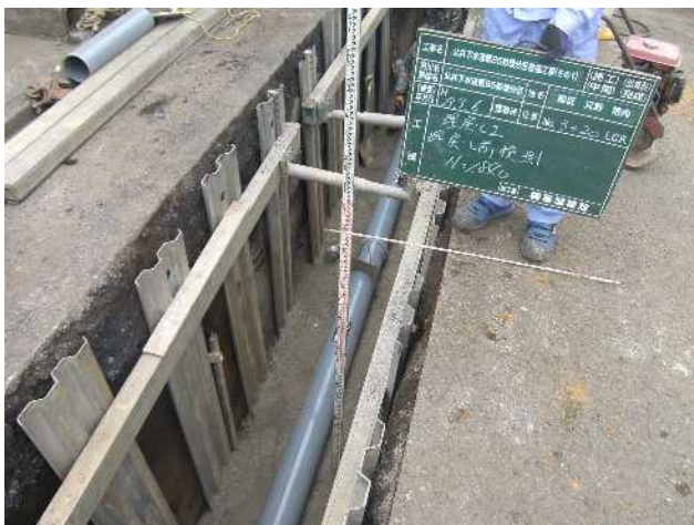
開削工法による下水道管の敷設
