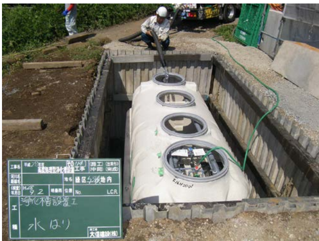
長屋への浄化槽設置(10人槽)
