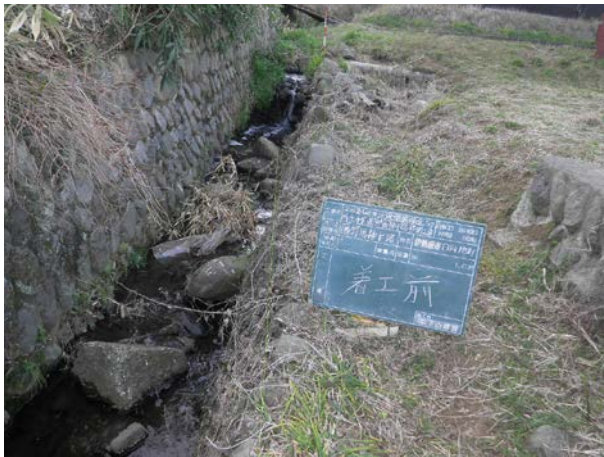
伊勢原市 藤野用排水路（生態系に配慮した整備） <整備前>
