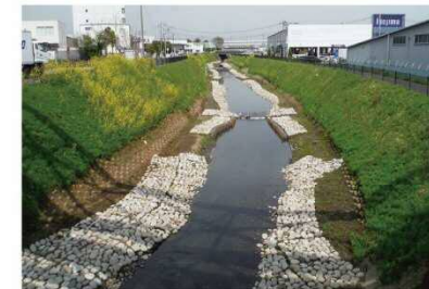
▲厚木市 恩曾川 自然石による護岸を整備し、生物の生息空間を確保しました。
