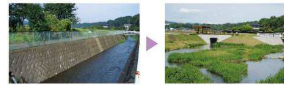
▲整備前 ▲整備後 コンクリートブロックによる護岸整備 瀬や淵ができたことで、自然浄化機能が向上
