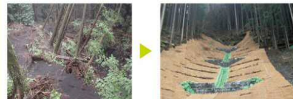
▲スコリア(富士山の火山噴出物)堆積層の流出 ▲土木的工法による取組例(カゴ枠工)
