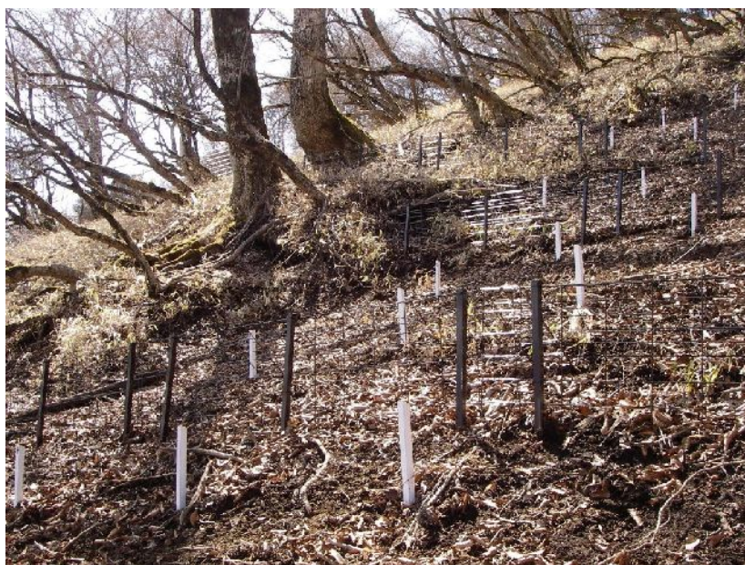
写真 金網筋工（茶色の網の中及び上部に落枝落葉を貯留させて土壌流出防止効果を発揮する施設）施工箇所内に設置した土砂移動量調査枠（白色鋼製柱が枠状に設置されている）
