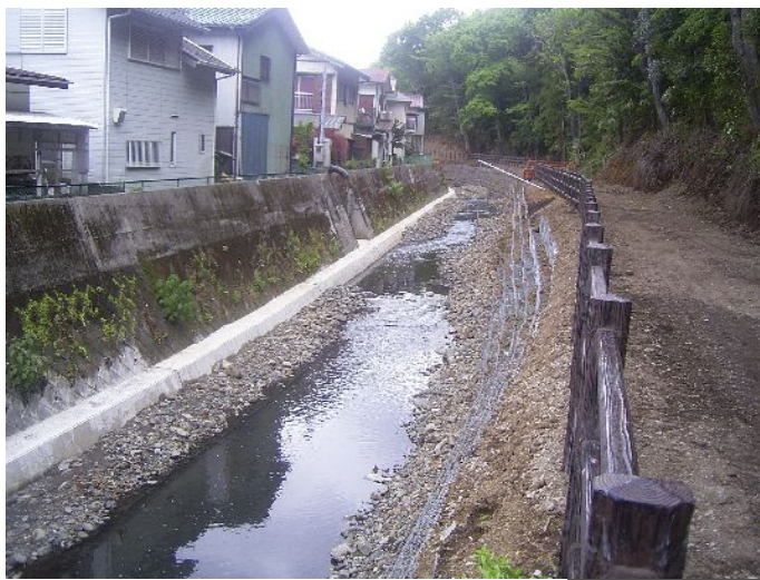
相模原市 姥川 改修工事
