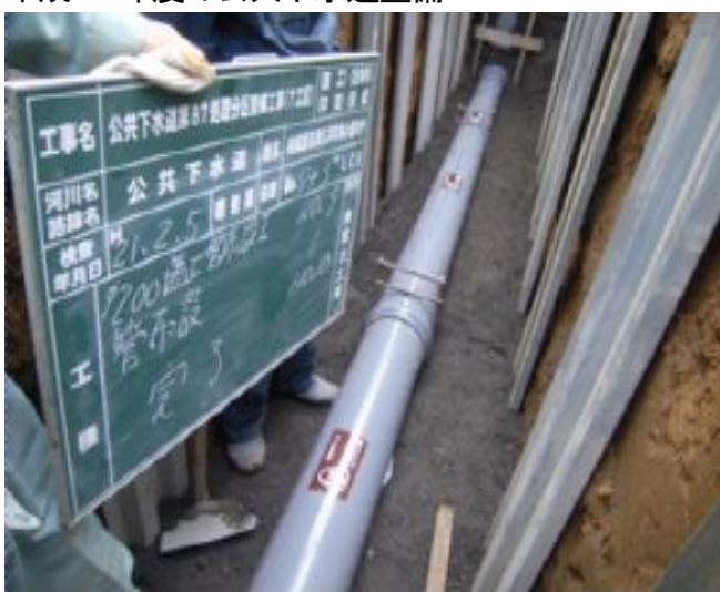
管路開削工事（相模原市津久井町）
