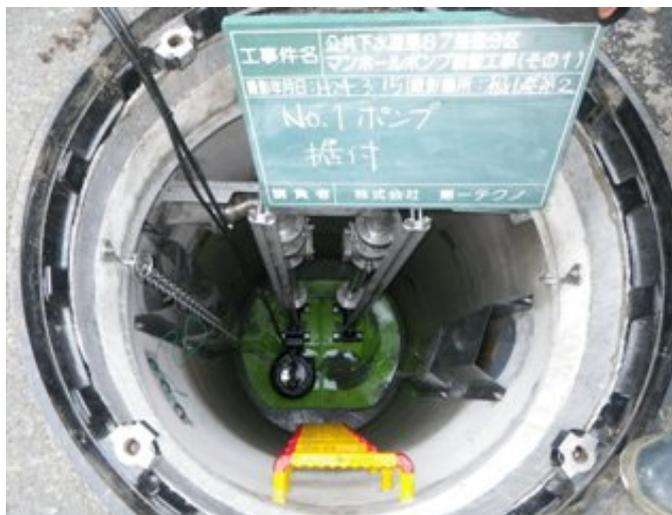
家庭から出る生活排水を集めて下水道処理場へ送る圧送ポンプをマンホールの中へ据付ける。
