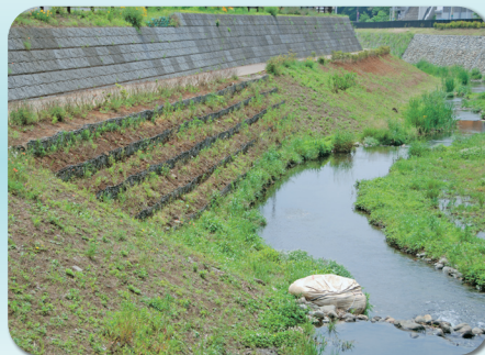
整備後 ⇒植物等が育つ環境づくりにより、生物が育まれている
