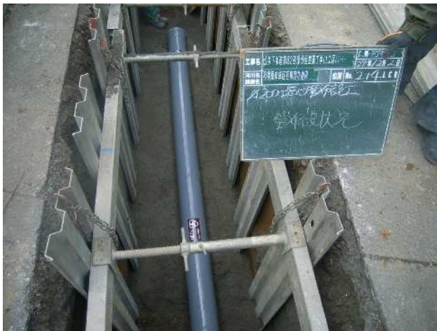
開削工法による下水道管の敷設
