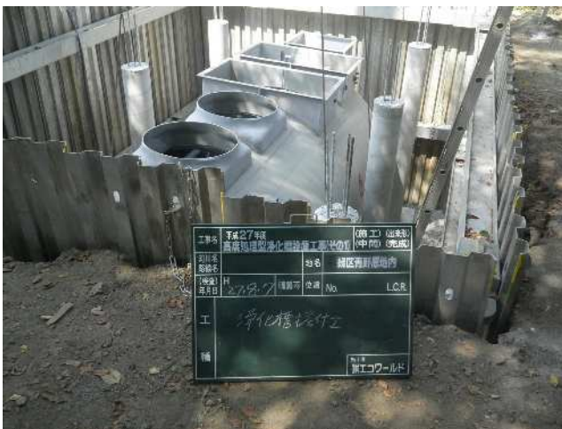
グラウンド管理棟への浄化槽設置(18人槽)
