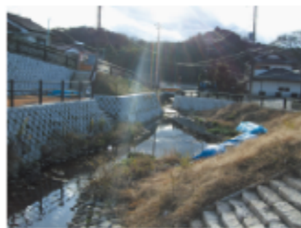
用地買収をし、多自然川づくりを行う（東谷戸川）
