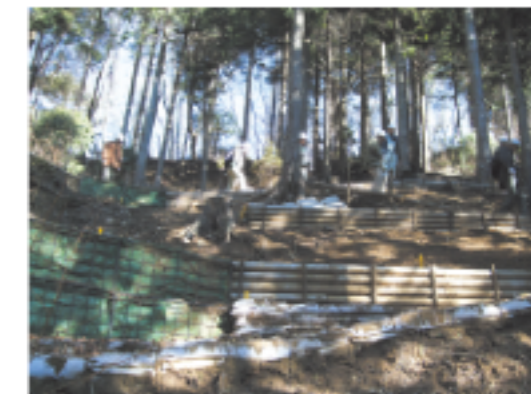
丸太柵で土砂が流れ出すのを防ぐ
