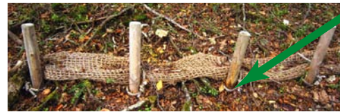
～リター（落葉）ロール工～
