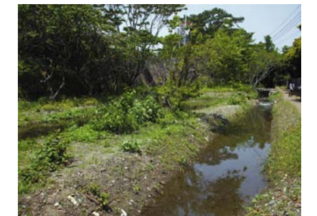
多自然護岸による河川整備（小田原市）
