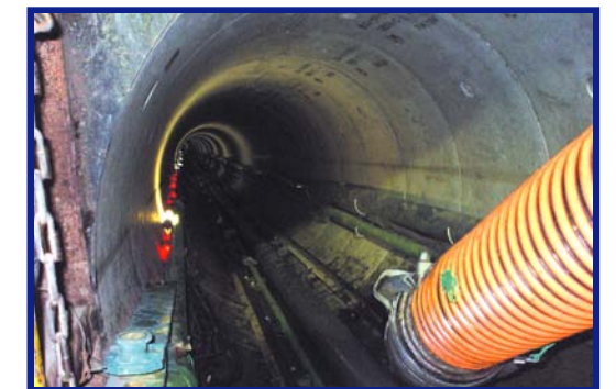
シールド工法で下水管を敷設
