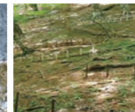
丸太柵などによる土壌流出の防止
