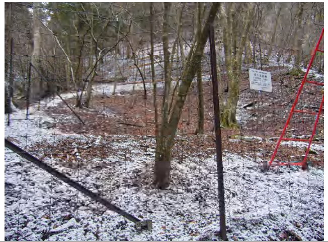
溪畔林 植生保護柵と丸太柵等設置（本谷川）
