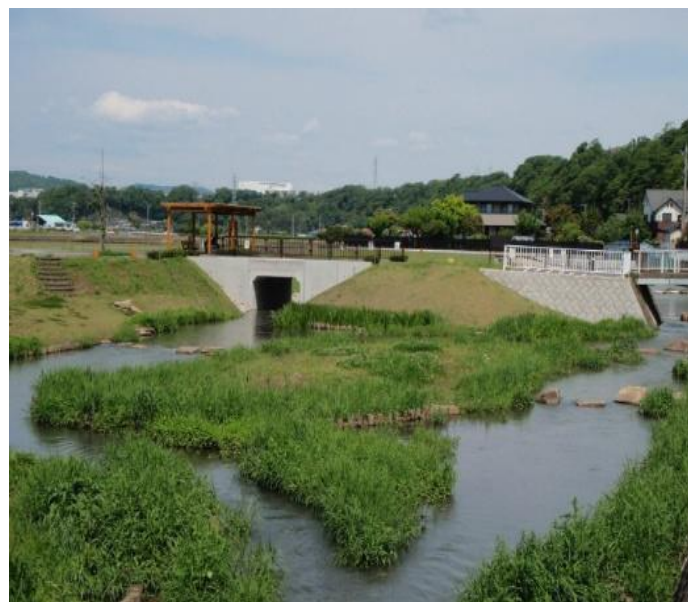
【厚木市：善明川（整備後）】
