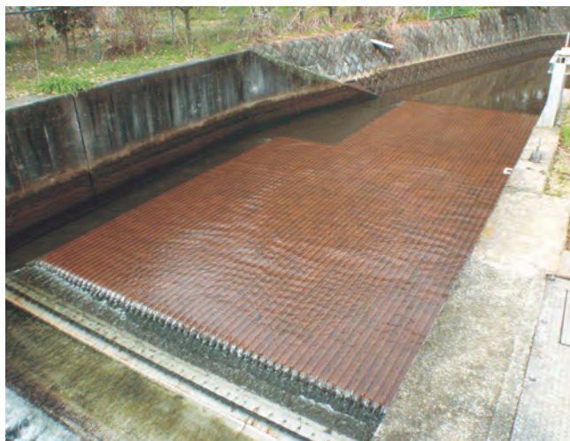
水質浄化ブロック（厚木市恩曾川）
