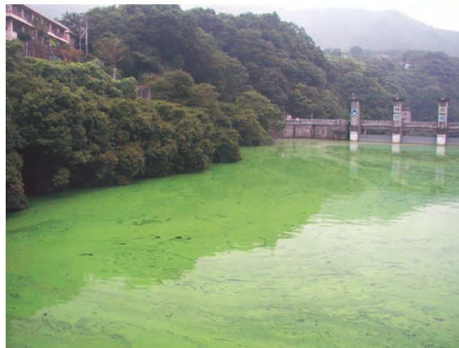
アオコの異常発生(相模ダム)
