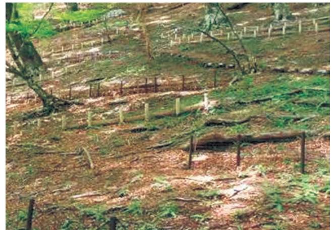
対策工の面的施工
