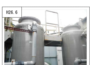
H26. 6 ⑦地下水保全対策 有機塩素系化学物質により汚染された地下水を施設の装置に通すことにより水質浄化を図った。(秦野市)
