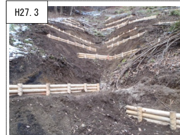
H27. 3 ③溪畔林整備 土壌流出が発生している、あるいは発生しそうな箇所に土壌保全工を実施した。(山北町仲の沢)
