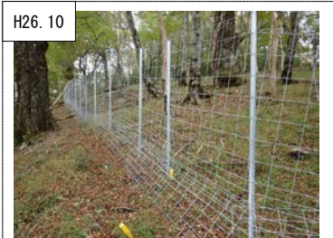
H26. 10 ②丹沢大山の保全・再生 シカによる採食を 방지、植生を回復させ、土壌を保全するため、植生保護柵を設置した。(山北町中川)
