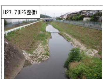
H27. 7 (H26 整備) ⑥河川・水路における自然浄化対策 川の流れに変化をつけ、水生生物が生息できる環境を創出した。(厚木市恩曾川)
