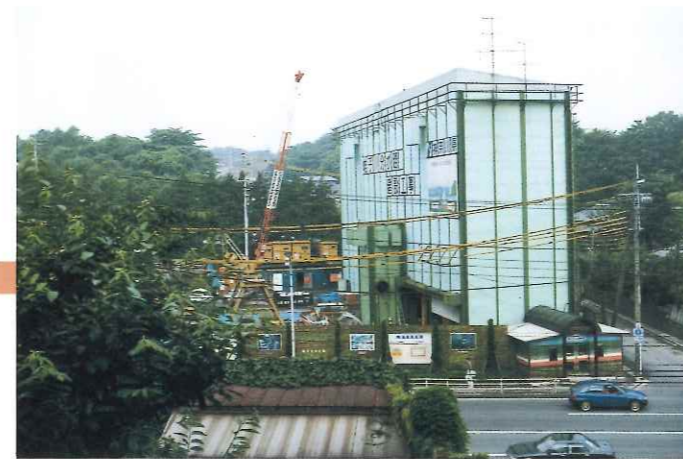
◎岡沢立坑 保土ヶ谷区岡沢町
