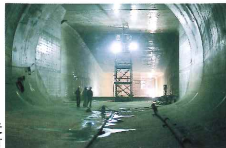
(トンネル接続部)
