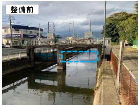
豪雨時の増水により破損した水門
