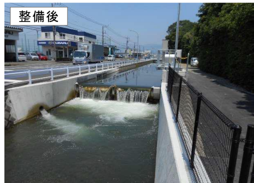
水路整備による排水機能の向上 (溢水被害の防止)
