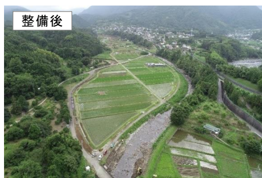
ほ場の大区画化による生産効率の向上
