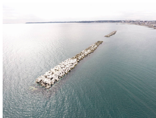
離岸堤（北下浦漁港海岸）
