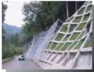
土砂崩落対策箇所の整備
