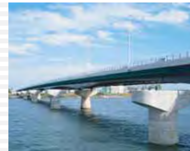
国道134号湘南大橋の4車線化（茅ヶ崎市～平塚市）
