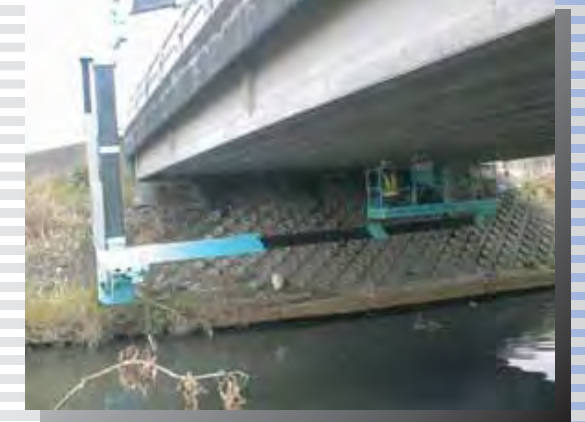
橋りょうの点検
