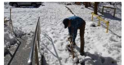
導線の除雪作業
