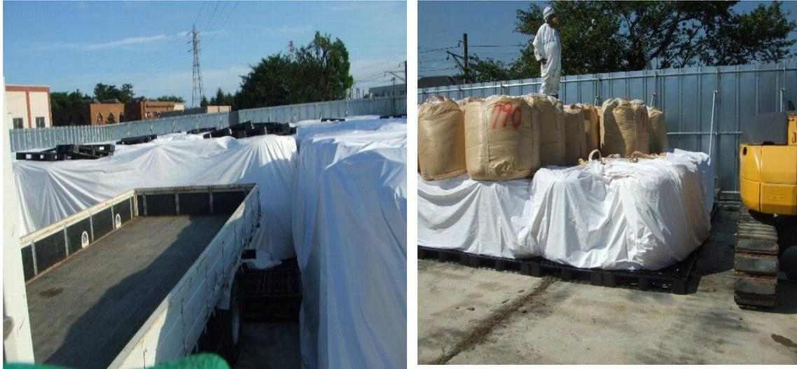
図 2-13 寒川浄水場旧排水処理施設 浄水発生土フレコンバック詰め保管状況
