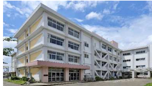
鉄骨ブレース等による耐震化工事後の校舎
