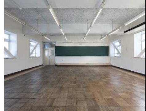
鉄骨ブレース等による耐震化工事後の校舎
