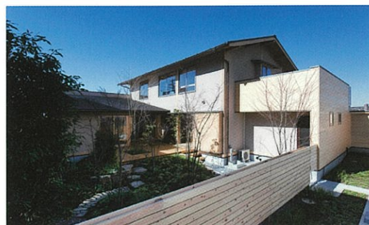
(かながわ県産木材を使用した住宅：藤沢市内)
