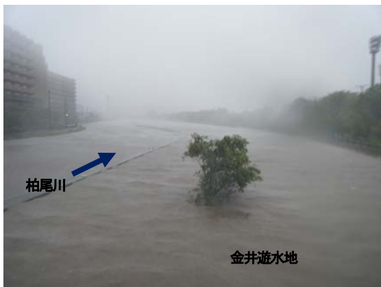
平成 26 年台風 18 号 柏尾川（横浜市栄区）
