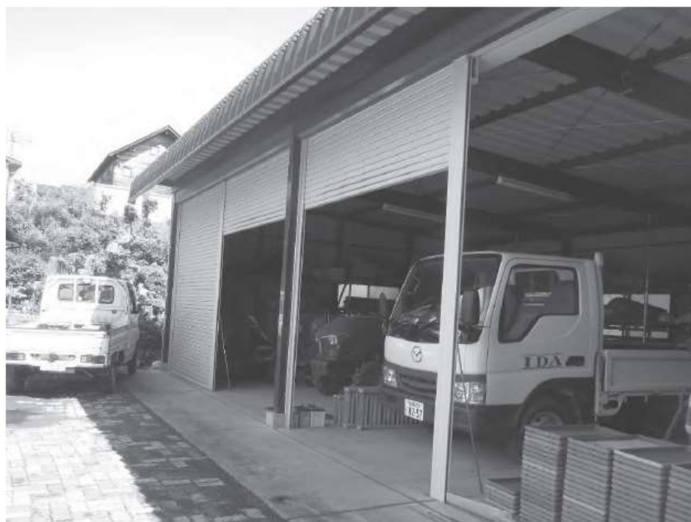
[市街化区域内の農業用施設 (農機具倉庫) の状況]
