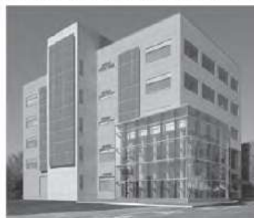
【ZEB (エネルギー自立型のビル)】
