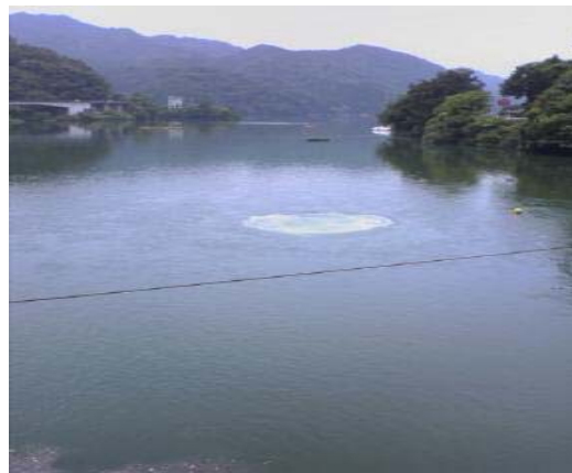
写真2 相模湖のエアレーション装置
