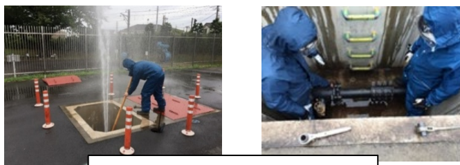
研修風景（漏水研修施設）
