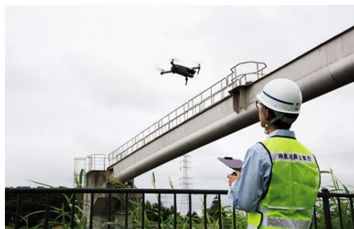
【図6】ドローンによる点検
