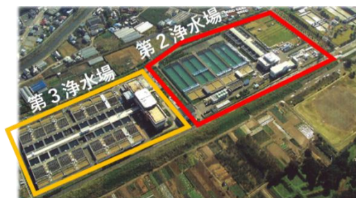
【図4】 寒川浄水場の俯瞰図
