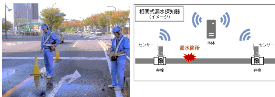
【図10】 漏水調査の様子
