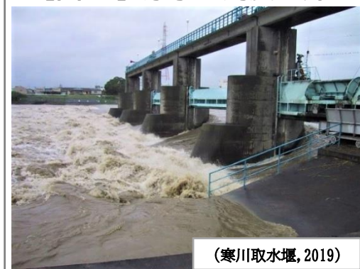
【図23】原水の濁度上昇
