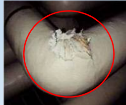
配管の曲線部(レベル2)
