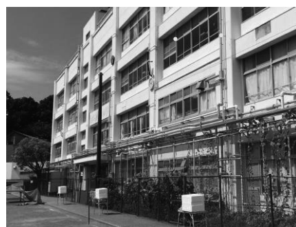
図3 熱線再帰フィルムを貼った教室(図の点線の枠)
