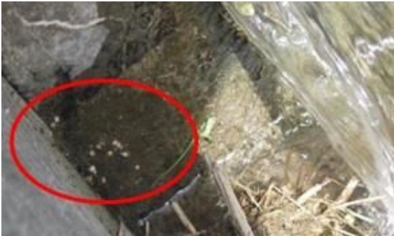
図5 排水路の壁に付着する肥料殻
