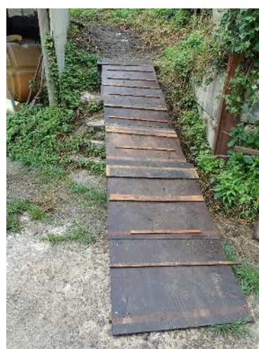
写真4 階段部分のスロープ設置
