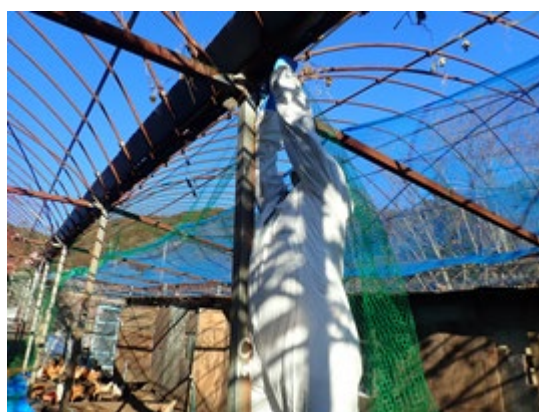
写真7 防鳥ネット設置作業
