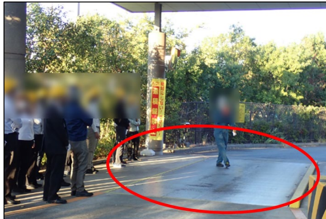
写真4 トラックの計量を行うはかり（赤丸）
