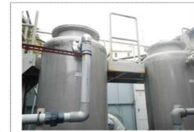
⑦ 地下水保全対策 有機塩素系化学物質により汚染された地下水を施設の装置に通すことにより水質浄化を図った。（秦野市）
