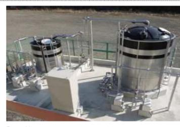
⑨ 相模川水系上流域対策 山梨県内の下水処理場に新たに設置したリンを取り除くための設備を稼働した。（山梨県桂川清流センター）
