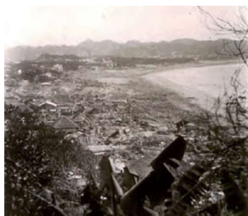
大正関東地震による鎌倉海岸由比ガ浜の津波被害
