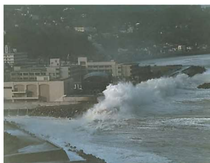
湯河原で発生した高潮・高波(H9.6)
