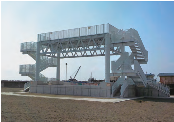
津波避難タワー
