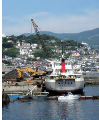
石材の積み込み (石材専用物揚場)
