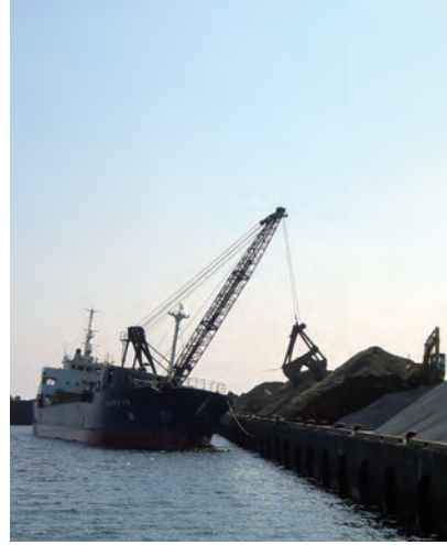
建設用資材の荷卸し（西岸壁）
