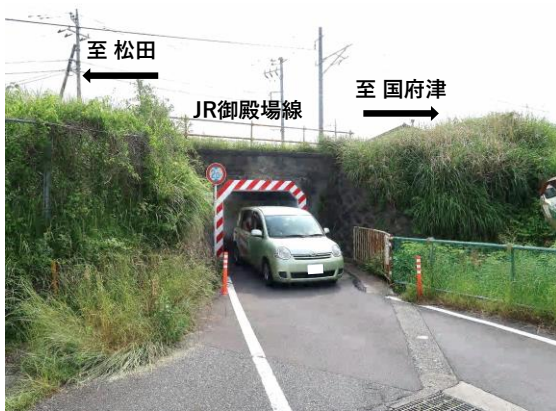
着工前の状況
