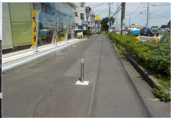
令和8年度事業予定箇所付近
