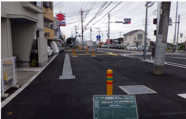
令和7年度歩道整備状況
