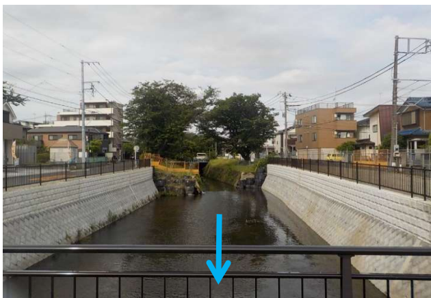
福田7号橋上流
