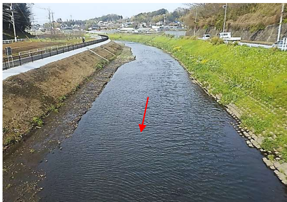
道庵橋上流(整備中)
